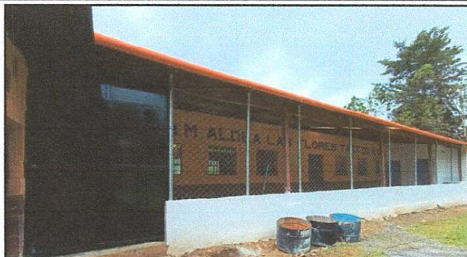
Foto 2: Vista frontal del porton instalado.
