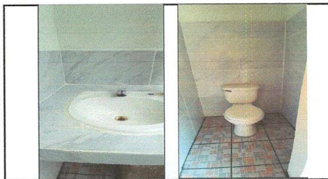
Foto 5: Lavamano, inodoro y piso instalado.
