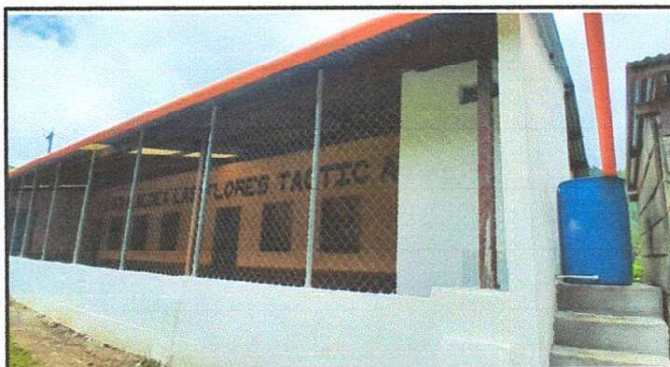
Foto 3: Vista lateral del cerco. También base y sistema de agua para drenaje y agua para lavamano.
